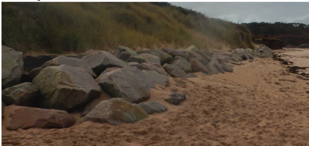
Fig. 47. Enrochement sur la plage du Guen
