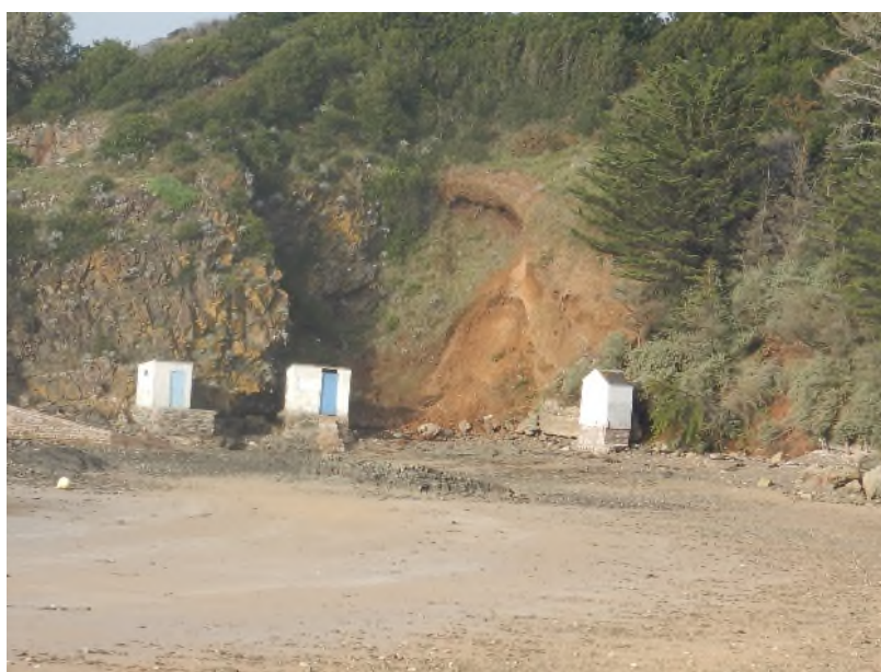
Fig. 4. Erosion au nord de la plage de Caroual
