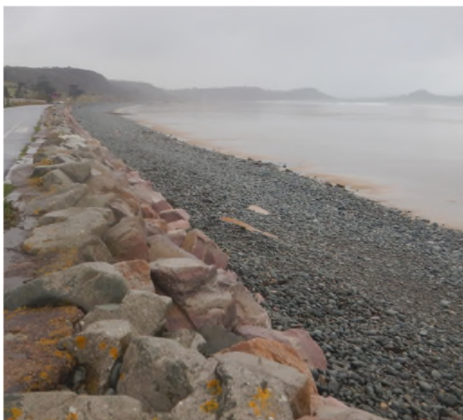
Fig. 48. Enrochement sur la plage de Saint-Pabu
